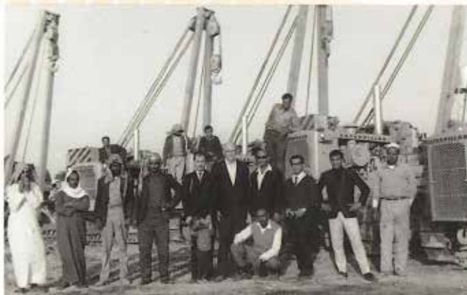
صورة توضح استعداداتنا للبدء في مشروع مد خط الأنابيب، ويظهر معي في الصورة مشرفو شركة أرامكو.
